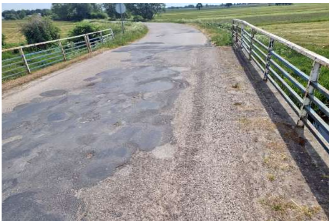
Fot. 21, 22. Rozbiórka i budowa obiektu mostowego w m. Dębe Małe – stan przed rozbiórką.
