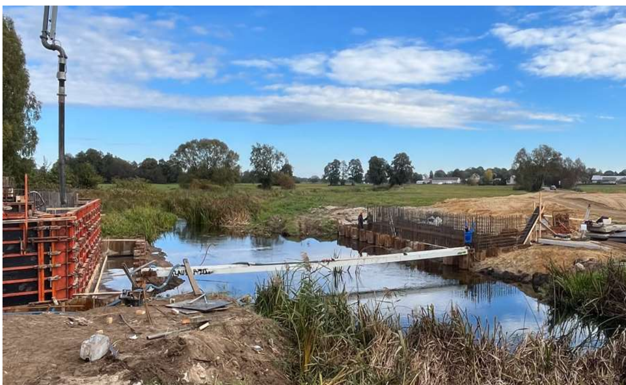
Fot. 25, 26. Rozbiórka i budowa obiektu mostowego w m. Dębe Małe
