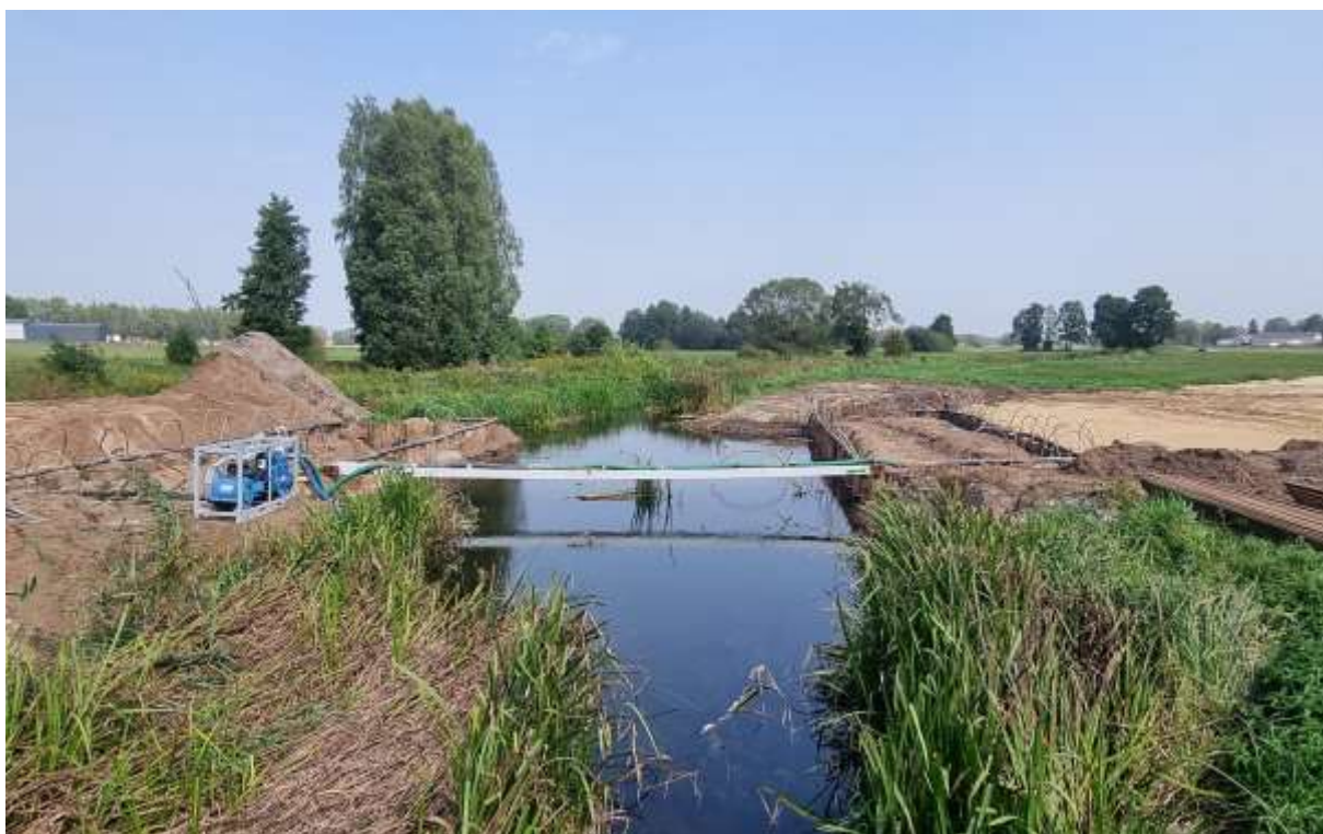
Fot. 23, 24. Rozbiórka i budowa obiektu mostowego w m. Dębe Małe
