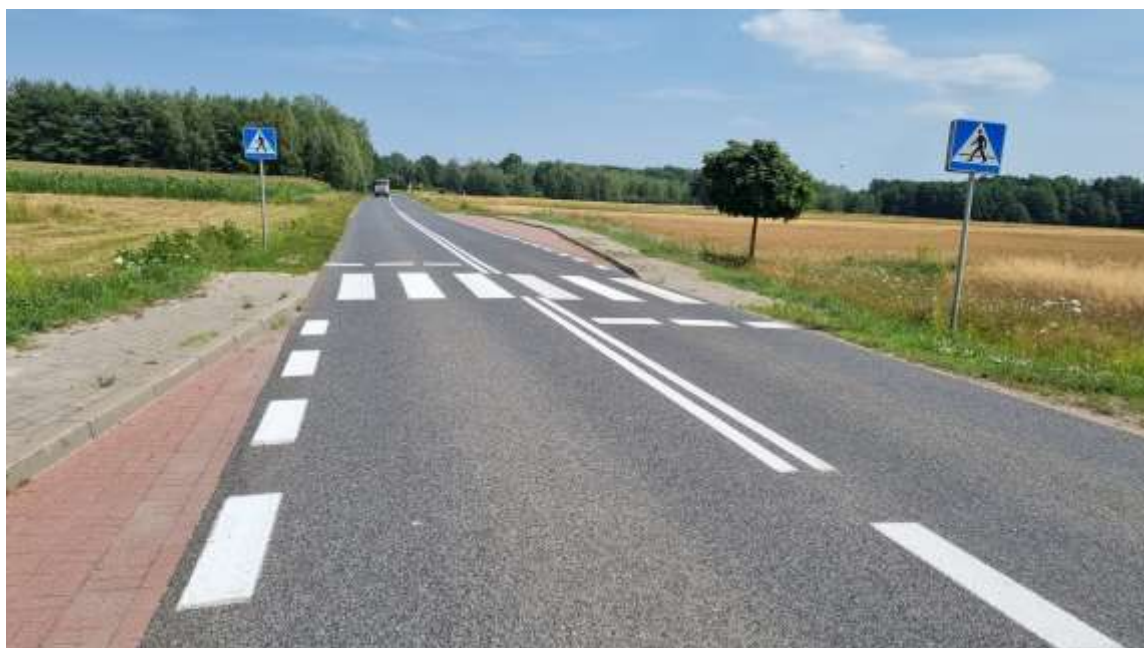
Fot. Odnowione oznakowanie poziome – DP 2227W
