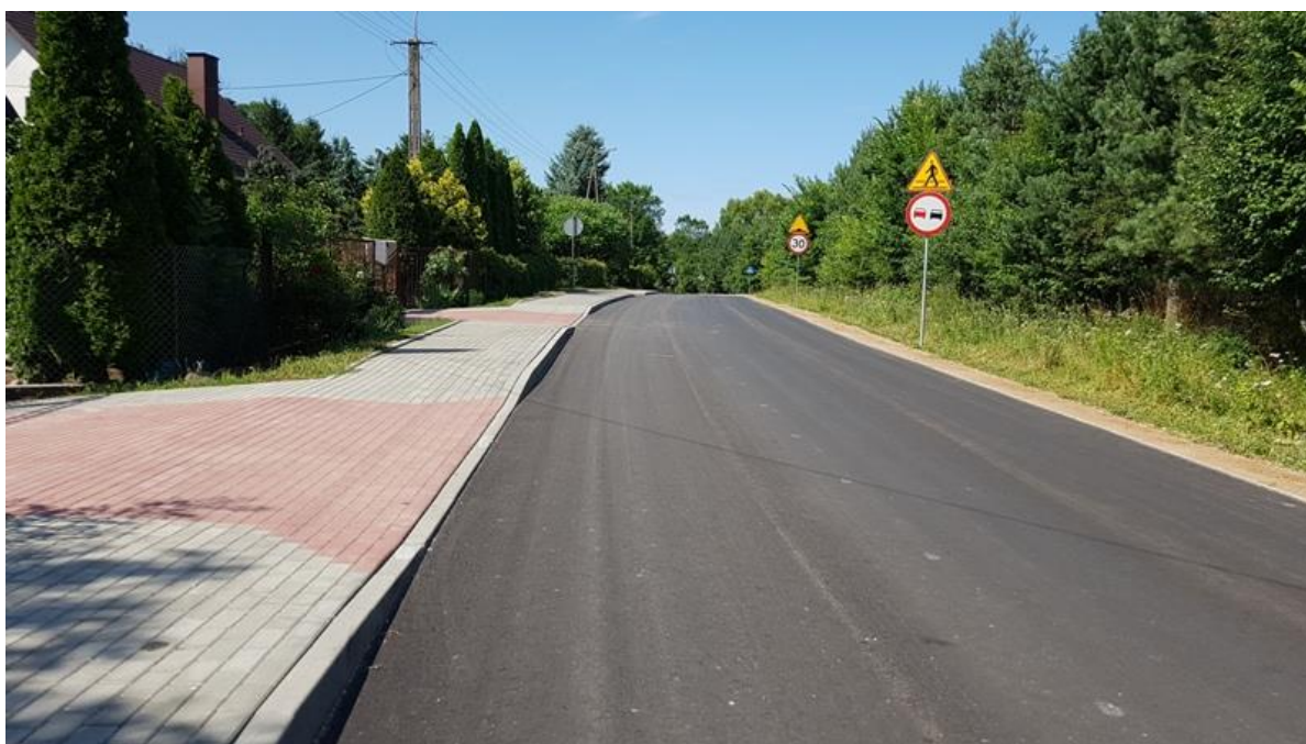
Przebudowana droga 2239W Wielgolas-Kamionka
