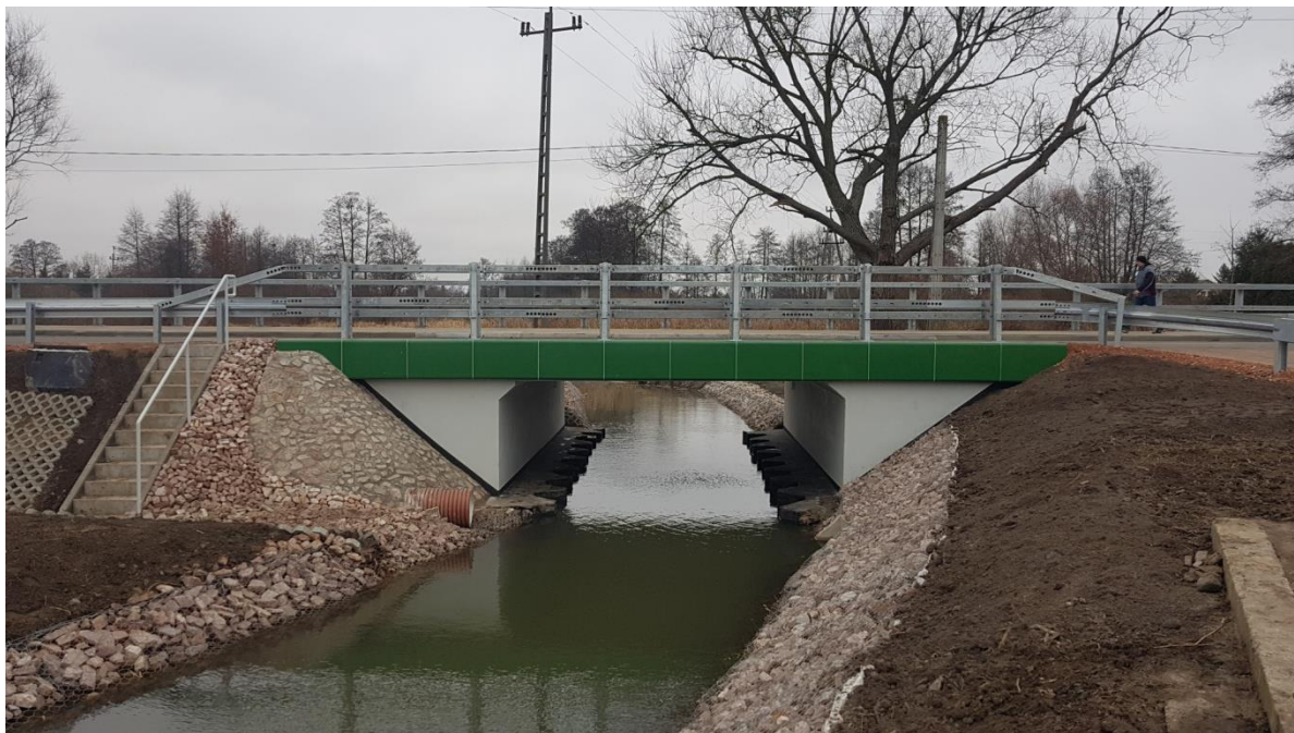
Rozbudowany most na drodze 2204W Halinów-Krzewina-Desno
