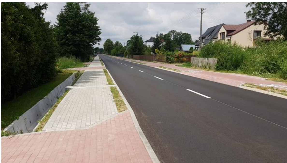
Przebudowana droga powiatowa nr 2230W Mińsk Mazowiecki-Cegłów-Mrozy
