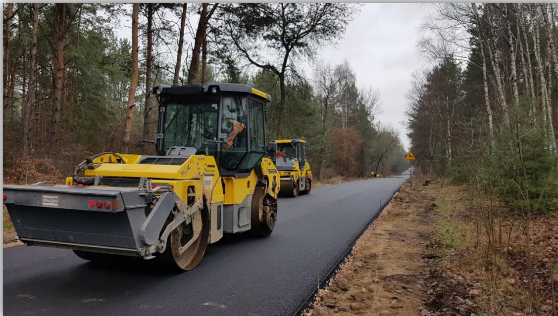
Przebudowa drogi nr 2247W Kałuszyn - do granicy powiatu
