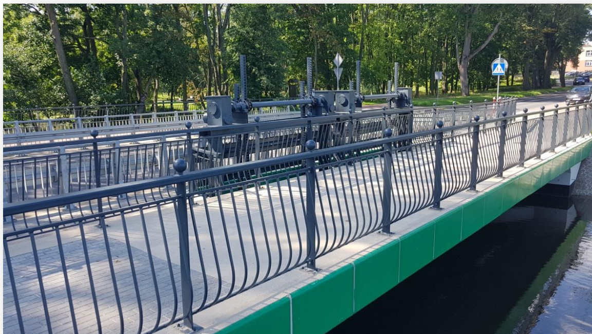
Kładka przez rzekę Srebrna (Mińsk Mazowiecki) na drodze nr 2277W
