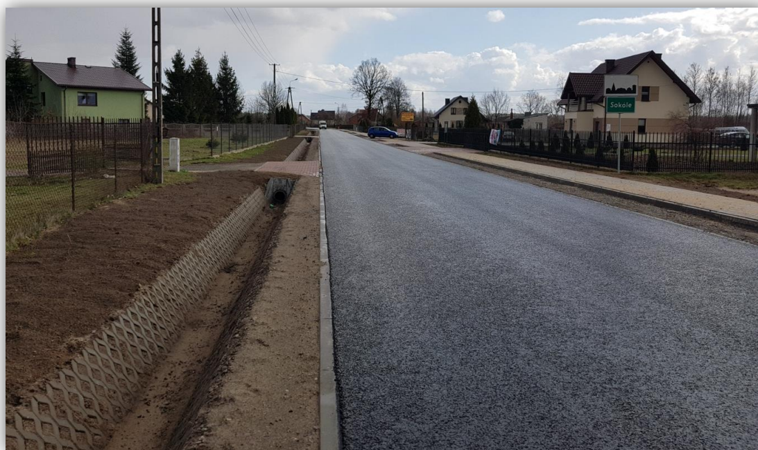
Przebudowa drogi nr 2214W Stanisławów - Młęczyn - Kamionka (Młęczyn)
