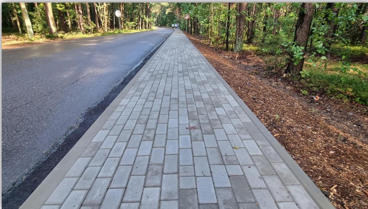
Przebudowa drogi powiatowej nr 2748W Rzakta – Józefów od km 5+400 do km 5+748
