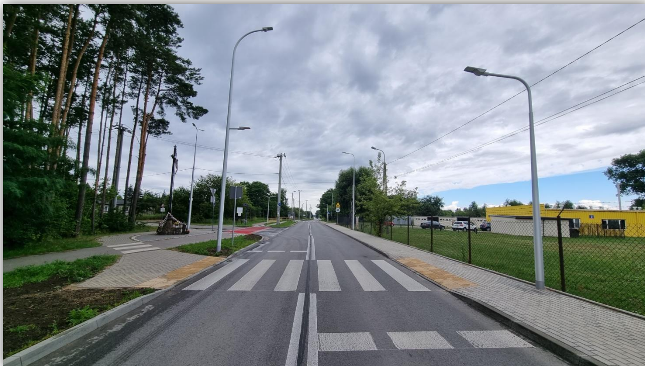
Przebudowa drogi powiatowej nr 4318W gr. powiatu – Okuniew – Halinów – Brzeziny – DK nr 2 od km 2+980 do km 6+770
