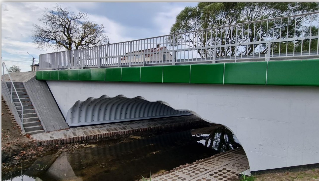
Rozbiórka i budowa obiektu mostowego zlokalizowanego w ciągu drogi powiatowej nr 1316W gr. powiatu – Parysów – Latowicz do dr. woj. nr 802 w km 10+310 z dojazdami
