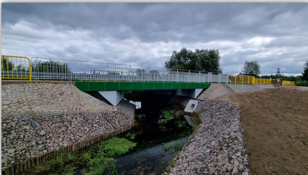
Przebudowa drogi powiatowej nr 4318W gr. powiatu – Okuniew – Halinów – Brzeziny-DK 2 od km 0+567 do km 1+886 polegająca na budowie chodnika z dopuszczeniem ruchu rowerowego wraz z budową dwóch kładek – kładka przez rzekę Długa
