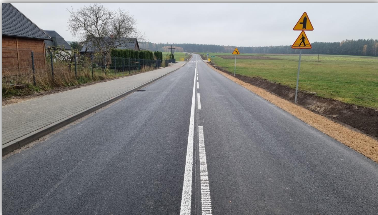
Przebudowa drogi powiatowej nr 2247W Kałuszyn – gr. powiatu od km 2+735 do km 4+576
