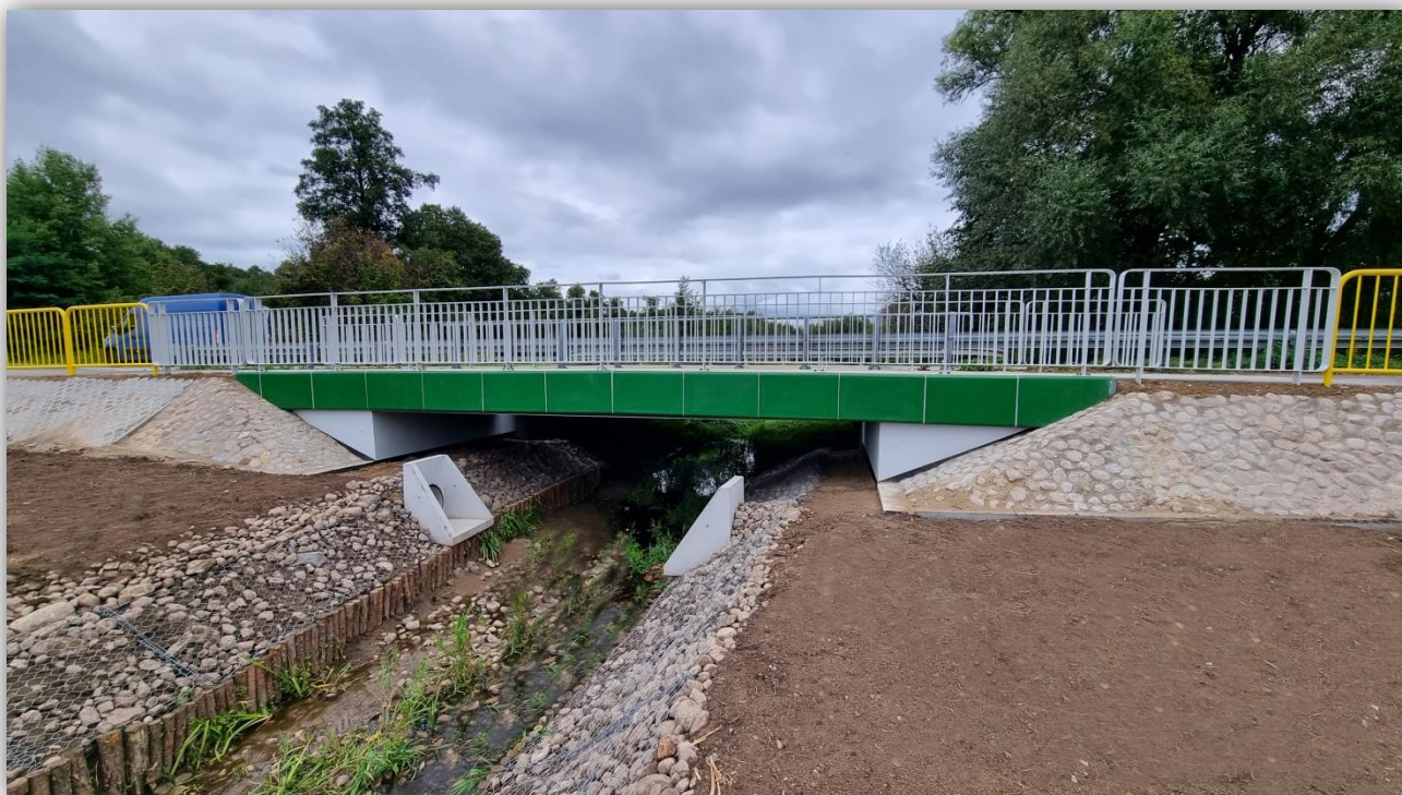
Przebudowa drogi powiatowej nr 4318W gr. powiatu – Okuniew – Halinów – Brzeziny-DK 2 od km 0+567 do km 1+886 polegająca na budowie chodnika z dopuszczeniem ruchu rowerowego wraz z budową dwóch kładek – kładka przez rzekę Ząza
