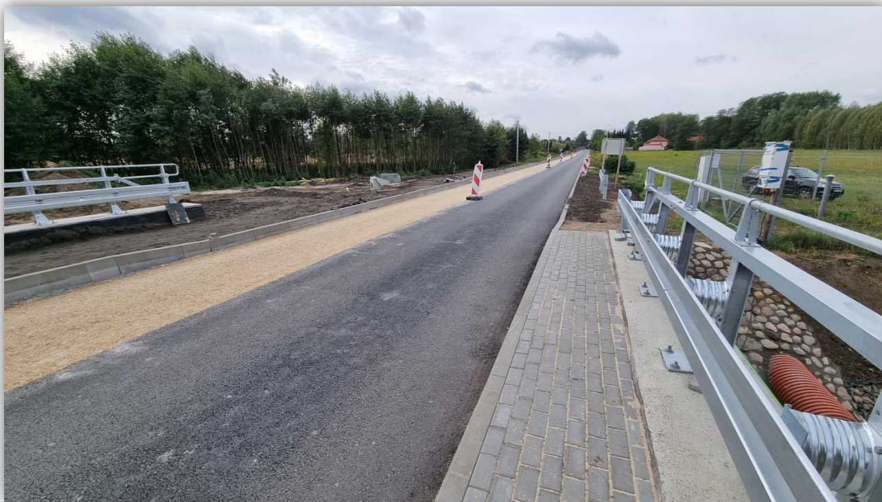
Rozbudowa drogi powiatowej nr 2230W Mińsk Mazowiecki – Ceglów – Mrozy od km 11+977 do km 14+035
