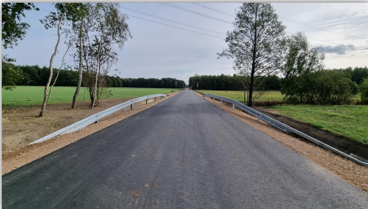
Przebudowa drogi powiatowej nr 2241W Posiadały – Kiczki – Wężyczyn – Jeruzal od km 5+660 do km 5+955
