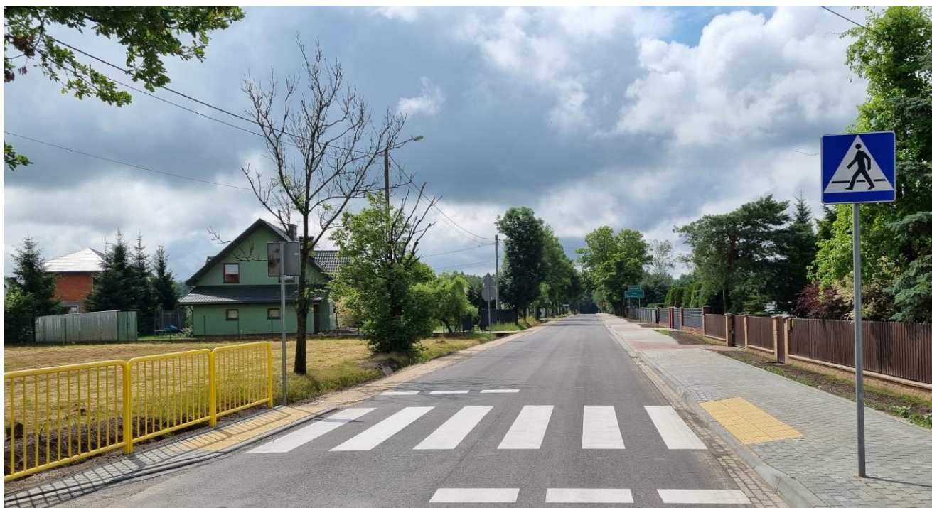
Przebudowa drogi powiatowej 2218W Dębe Wielkie - Helenów polegająca na budowie chodnika w Pustelniku wraz z odwodnieniem
