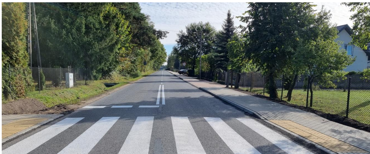
Przebudowa drogi powiatowej nr 2227W Mińsk Maz.-Niedziałka-Jakubów do drogi Jędrzejów-Dobre, polegająca na budowie chodnika
