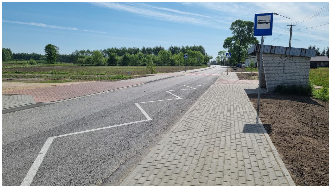
Przebudowa drogi powiatowej nr 2219W Arynów-Cyganka-Cięciwa do drogi Wielgolas Brzeziński-Kąty Goździejewskie Drugie, polegająca na budowie chodnika w msc. Cyganka
