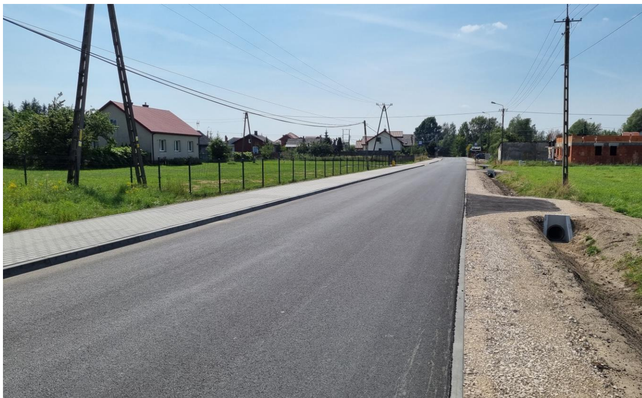
Przebudowa drogi powiatowej nr 2202W Stary Konik-Chobot
