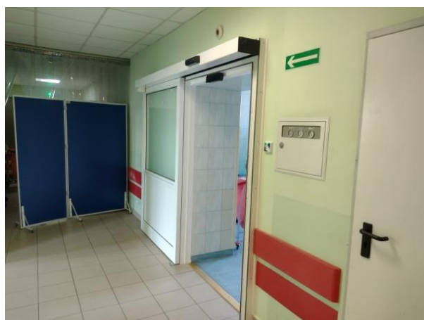
Modernizacja Szpitalnego Oddziału Ratunkowego poprzez rozszerzenie otworów i wymianę stolarki wewnętrznej
