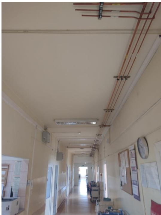
Modernizacja budynku tlenowni wraz z wymianą instalacji łączącej zbiornik z tlenownią oraz rozszerzeniem instalacji dla gazów medycznych w oddziałach szpitalnych
