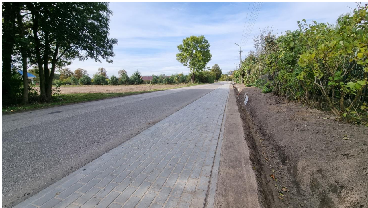
Przebudowa drogi powiatowej nr 2242W Stara Wieś-Siodło-Kuflew polegająca na budowie chodnika
