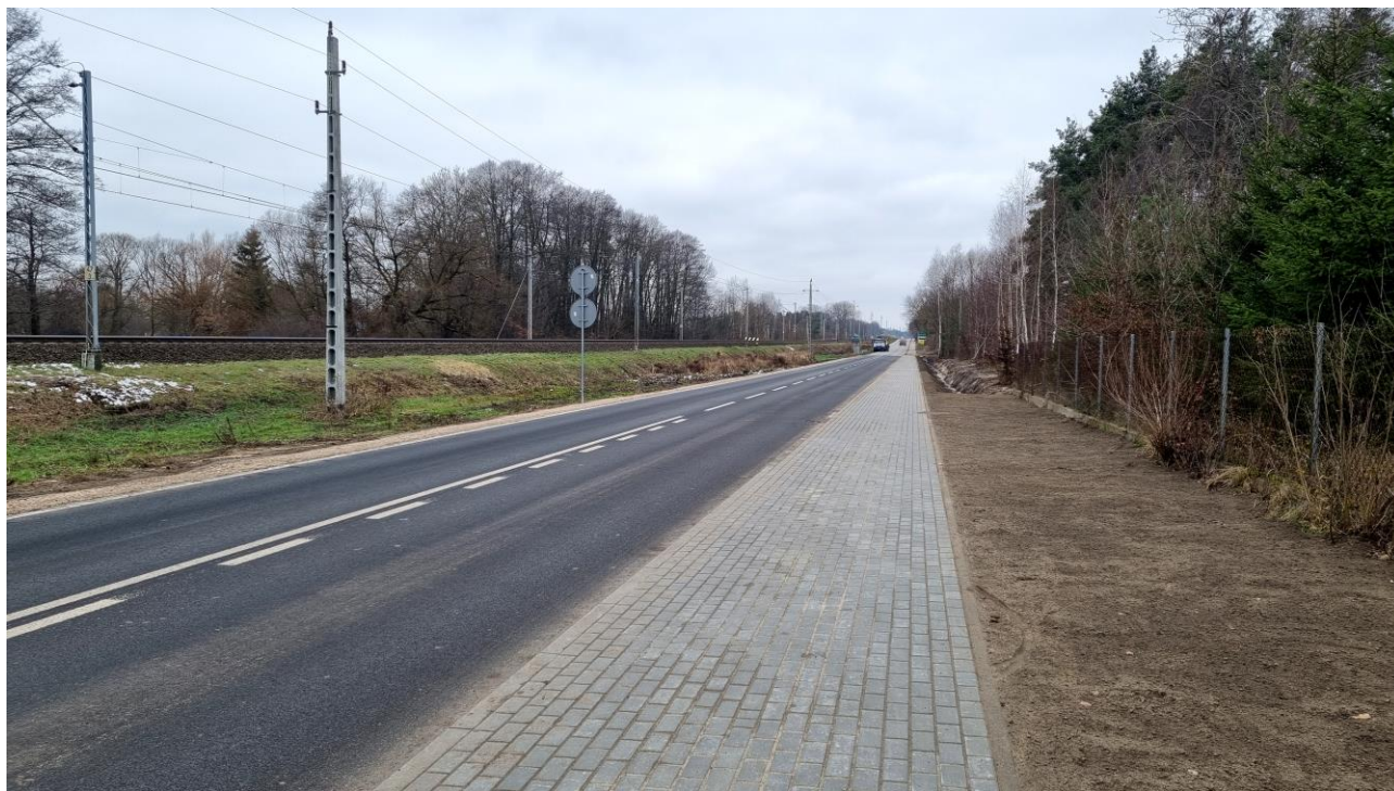
Przebudowa drogi powiatowej nr 2230W Mińsk Mazowiecki-Cegłów-Mrozy
