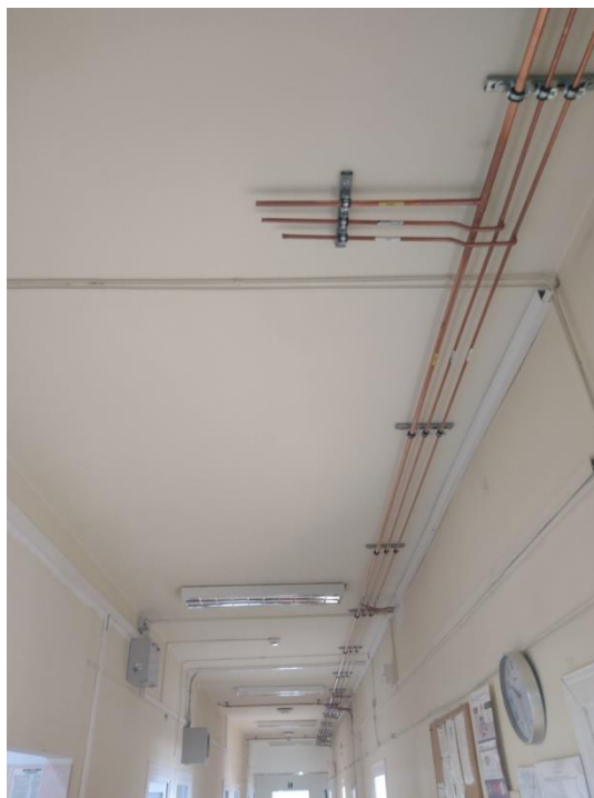
Modernizacja budynku tlenowni wraz z wymianą instalacji łączącej zbiornik z tlenownią oraz rozszerzeniem instalacji dla gazów medycznych w oddziałach szpitalnych
